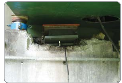
3. 소형유압잭 및 체인블럭 등을 이용한 세팅 후 가용점
