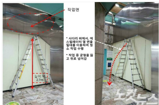
41 인천지하철 A형사다리 사망사고 발생 당사의 안전인증 타워형 안전작업대로 교체
