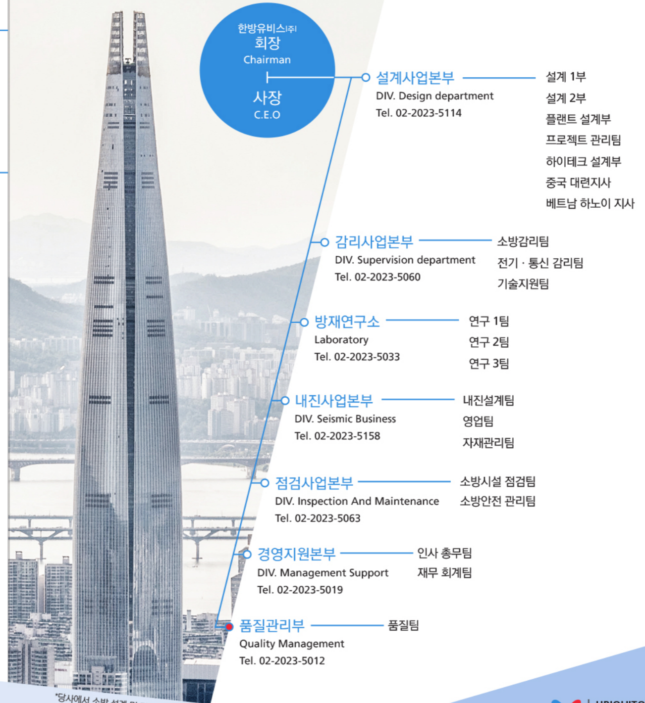
*당사에서 소방 설계 및 감리, 방재연구를 수행한 롯데월드타워 전경
