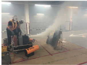
Hot Smoke Test (e편한세상 송도)
