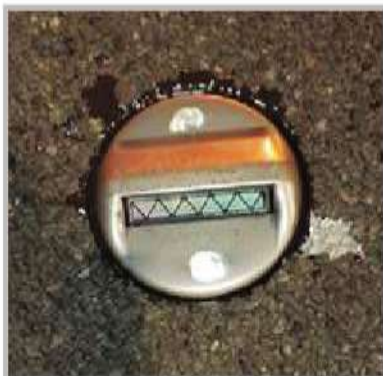
7. 표지병 설치 후1
