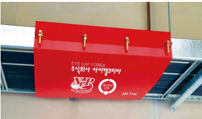
[트레이 300mm에 방화커버 설치 사진]
