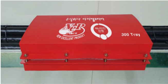
[트레이 300mm에 방화커버 설치 사진]
