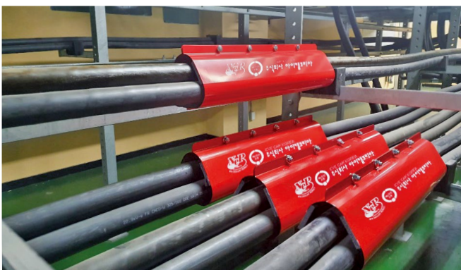
[송전 케이블 325sq에 방화커버 설치 사진]
